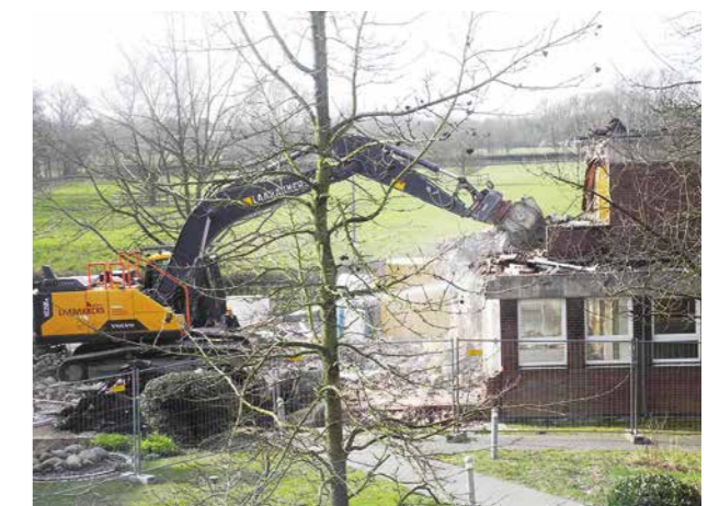
Abriss des Altbaus des Landhauses
