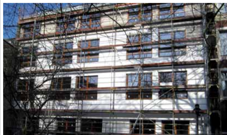
Eingerüstet ist das Josefs Haus, das die Caritas bis 2012 umbauen lässt. (Foto: rs)
