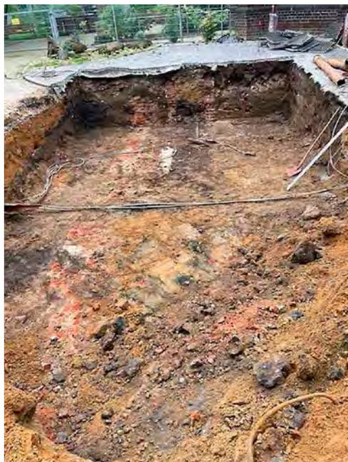
werden muss. Der Baubeginn der Rückhalte-kammern wurde auf den 8. April 2024 terminiert. Die Sanierung erfolgt in zwei Bauabschnitten, der erste ist im Bereich des Parkplatzes. Hier wurden die Rückhalte-kammern eingesetzt und ein neues Abwasserrohr, durch das Wohnhaus bis zur Straße, verlegt. Dies wurde auch mit einem Rückschlagventil versehen, damit kein Abwasser aus dem städtischen System zurück in das Rückhaltebecken fließen kann. Der Abschnitt wurde bis zum 16. Mai weitgehend fertiggestellt.
